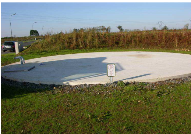
Réserve d'eau enterrée
