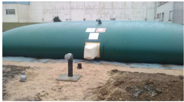
Réserve d'eau souple de 120 m 3 utilisable par le biais d'une colonne d'aspiration de 100 mm
