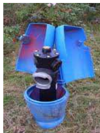
Poteaux d'aspiration de 100 mm à réseau sec, munis d'une seule sortie de 100 mm. Pas de volant ni de carré de manœuvre.
