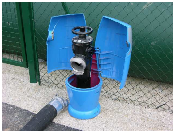
Poteau d'aspiration classique de 100 mm, muni d'une seule sortie de 100 mm et d'un volant de manœuvre
