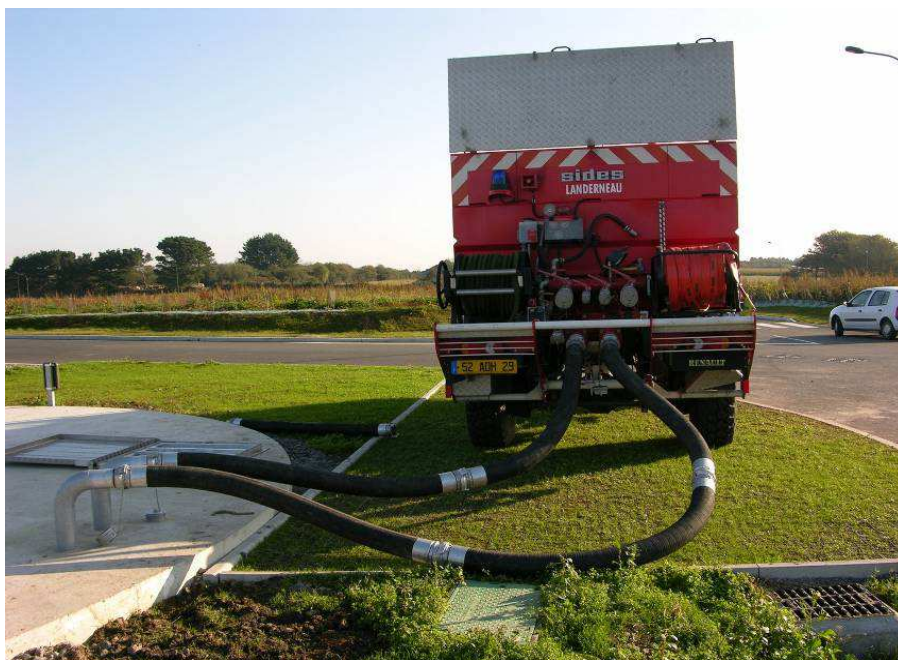
Mise en aspiration d'un engin pompe sur deux colonnes d'aspiration reliées à une réserve d'eau enterrée
